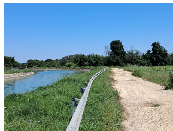
Canal Philippe Lamour (BRL) Confortement de la berge - Commune Aigues - Vives
